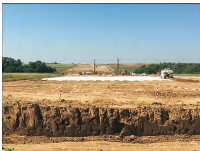
Obr. 159 Dálnice D1 Přerov – Lipník nad Bečvou – úprava zemín (spraše CL) v podloží nízkého násypu (2 m) vápnem (05/2016)
